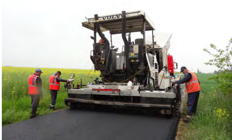
Pose de l'enrobé
