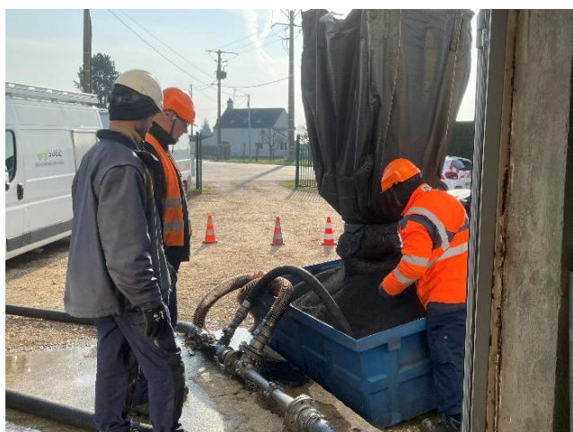
Mise en place du charbon actif dans les cuves
