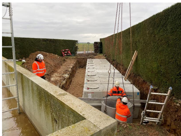
Installation des cuves de décantation
